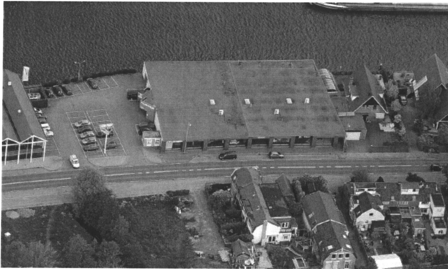
Bestaande situatie Hoorn 100
