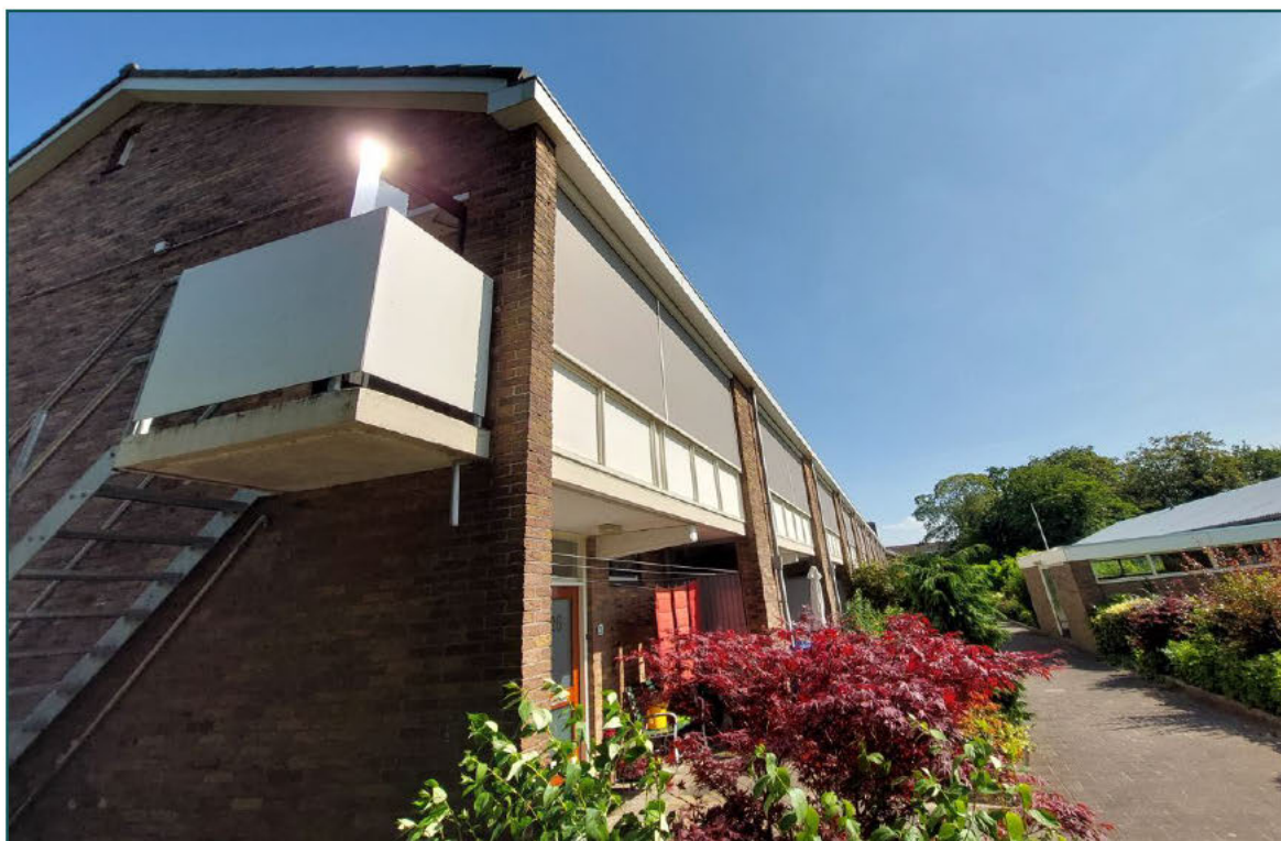
Figuur 2 De bebouwing bestaat uit een appartementencomplex.
