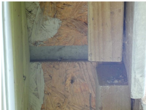
Figuur 15 Opening in de overkapping met steenwol
