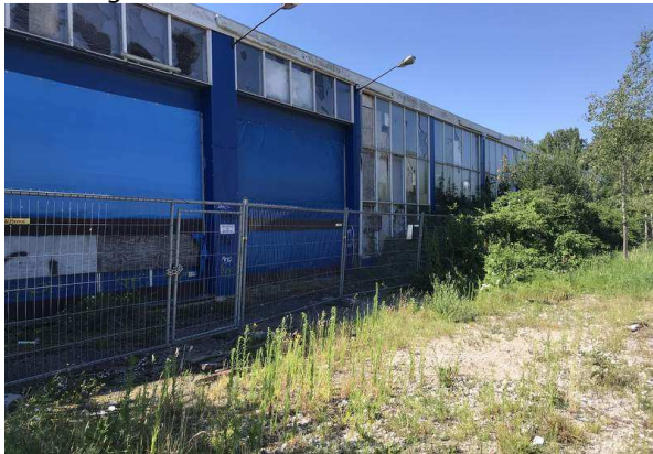
Figuur 6. Overzicht van de noordkant van de bedrijfshal. Dit deel grenst aan de Lineausweg, de berm is overgroeid met bramen.
