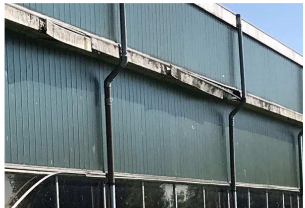
Figuur 9. Aan de zuidzijde liggen enkele boeiboorden los, waardoor er ingangen zijn voor vleermuizen en vogels.
