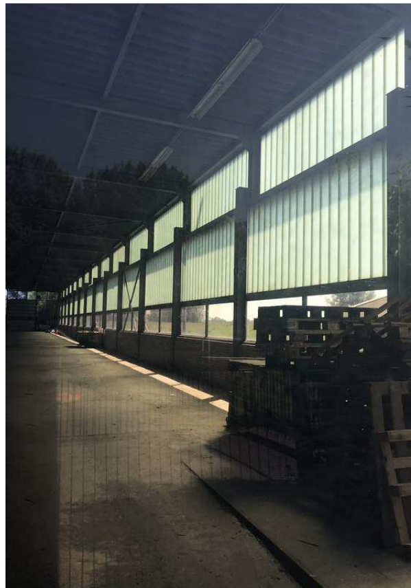
Figuur 11. Interieur van de bedrijfshal.
