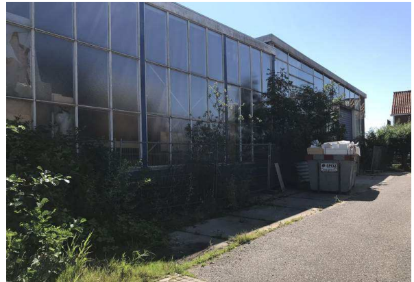
Figuur 7. Overzicht van de oostkant van de bedrijfshal.
