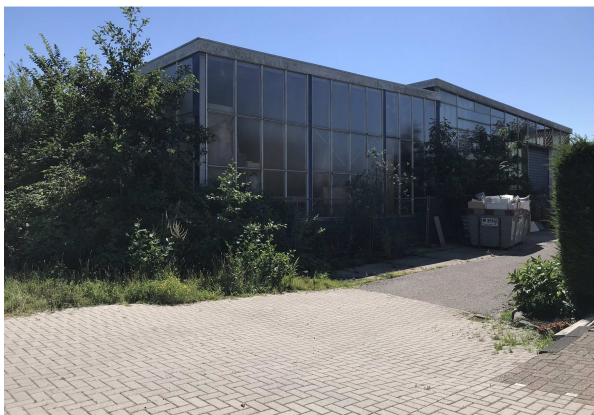
Figuur 12. Overzicht van de oostkant van de bedrijfshal.
