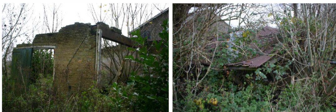
Figuur 4.1.3. Twee ingestorte gebouwen.
