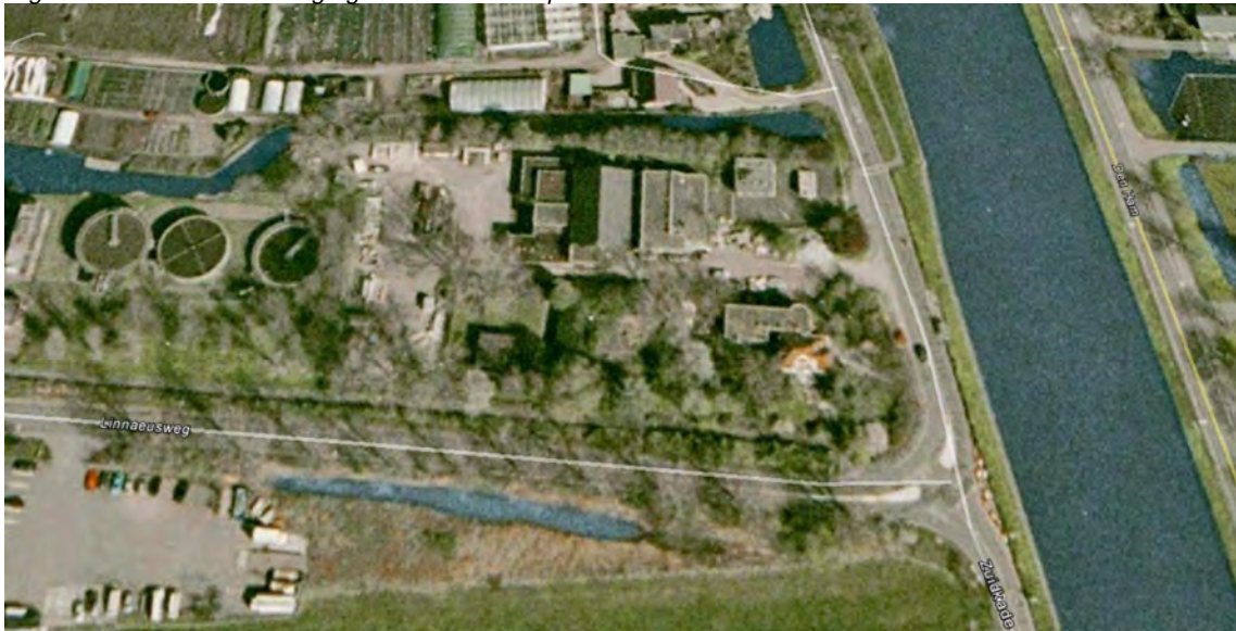
Figuur 1: Luchtfoto voormalige gasfabriek Boskoop
