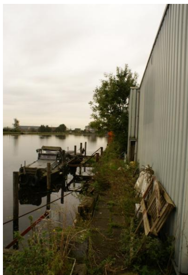
Foto 35: De kademuur (locatie 8)
