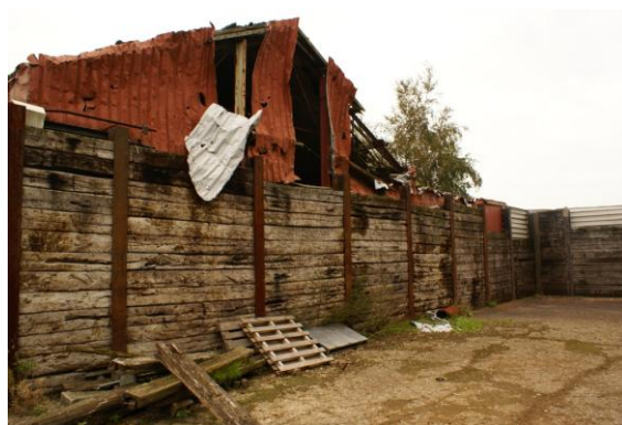
Foto 44: Zijkant van het gebouw (locatie 9)
