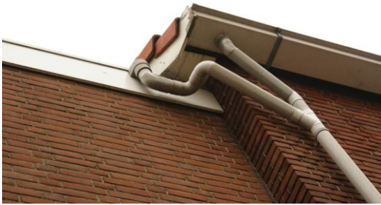
Foto 9: Beplating en dakpannen (locatie 3)
