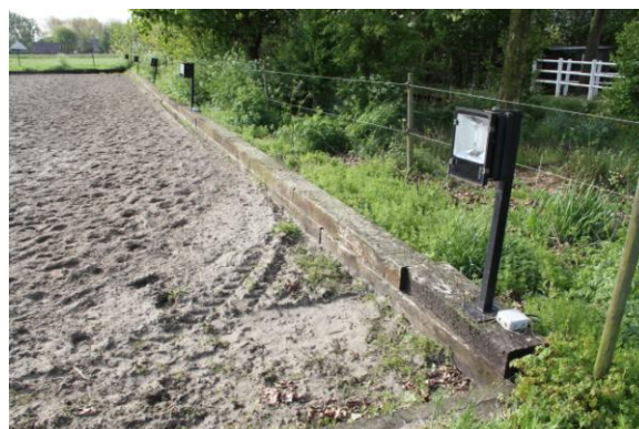
Rijbaan met bielzen en lage lichtmasten
