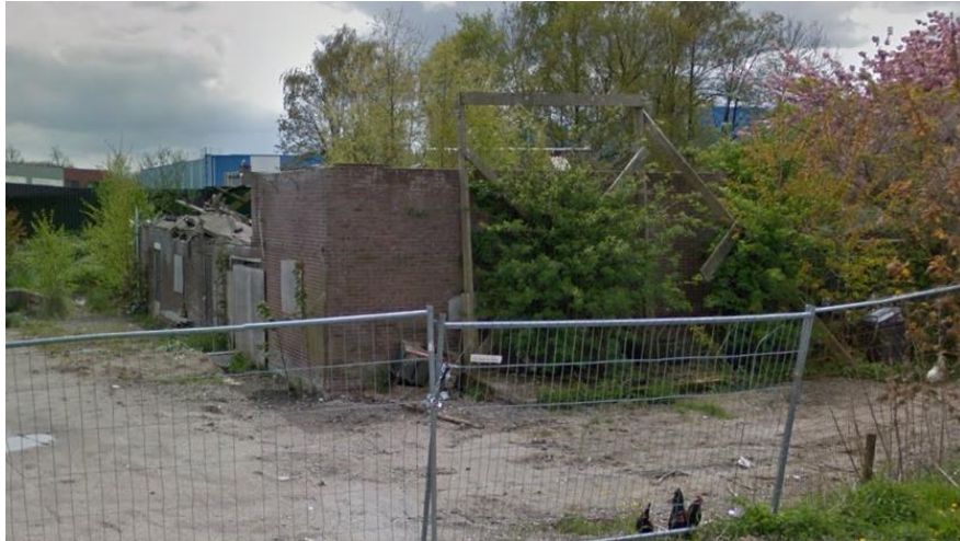
Afbeelding 5: Ingestorte voormalige agrarische schuur
