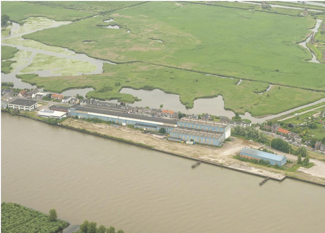
Afbeelding 2.1.: Vogelvlucht van de bestaande loodsen en het achtergelegen rivierlandschap
