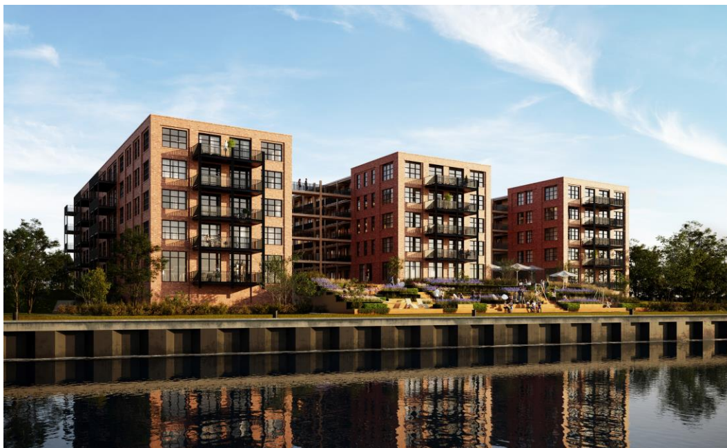
Afbeelding 2.9.: Loodsappartementen gezien vanaf de kade, met op de voorgrond de trappen / horecaterras aan het water (bron: Van Aken architecten)
