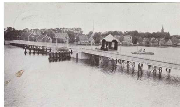
Koog aan de Zaan, de Noorder-Brug.
