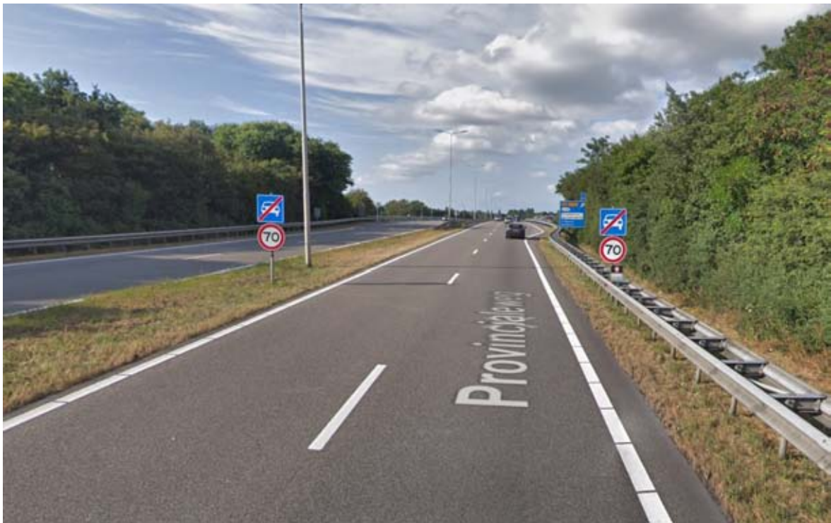
N246 Zuidzijde viaduct richting noorden
