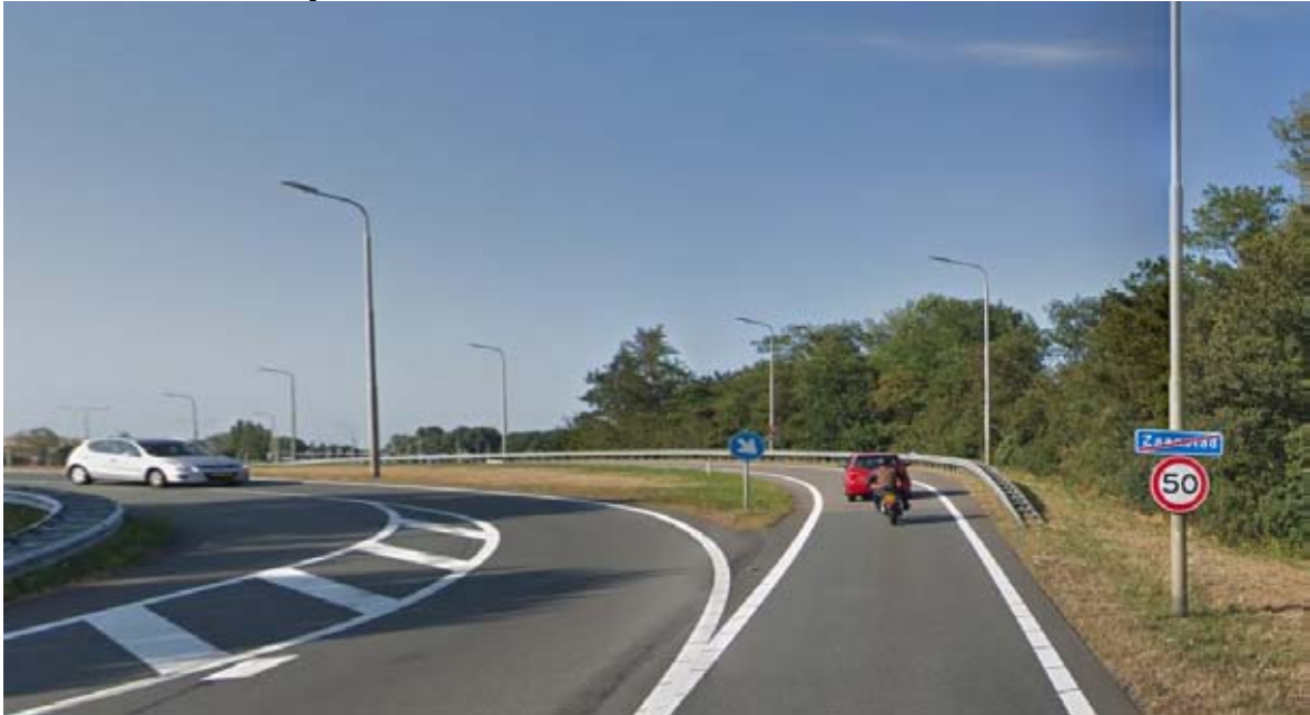
Oprit N246 richting noorden
