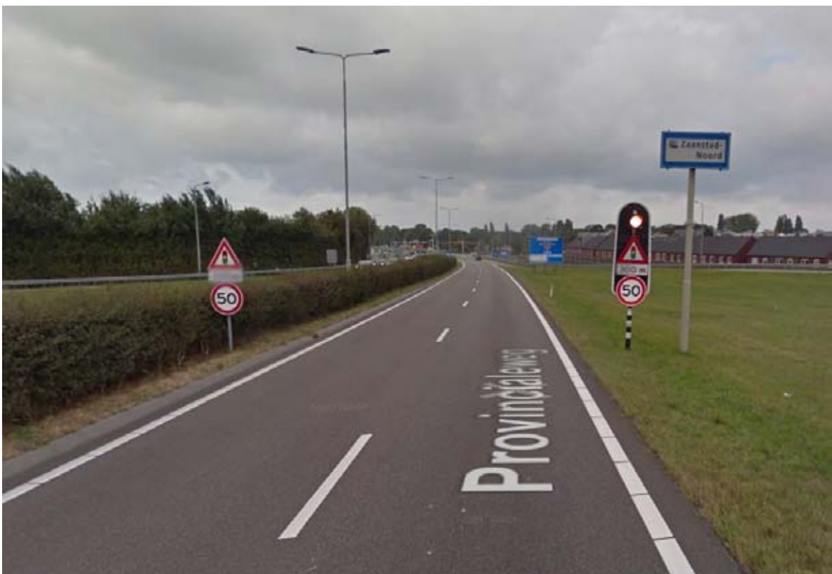
N246 Ten noorden van viaduct richting noorden
