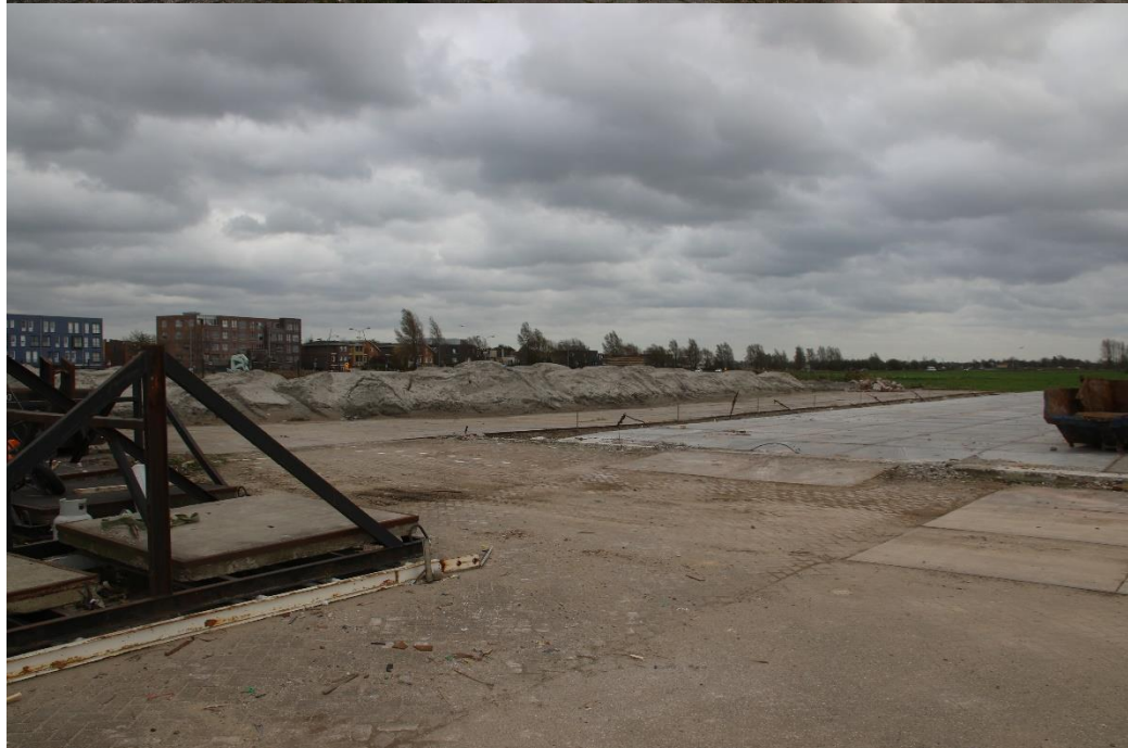
Locatie met huidige verharding en werkzaamheden
