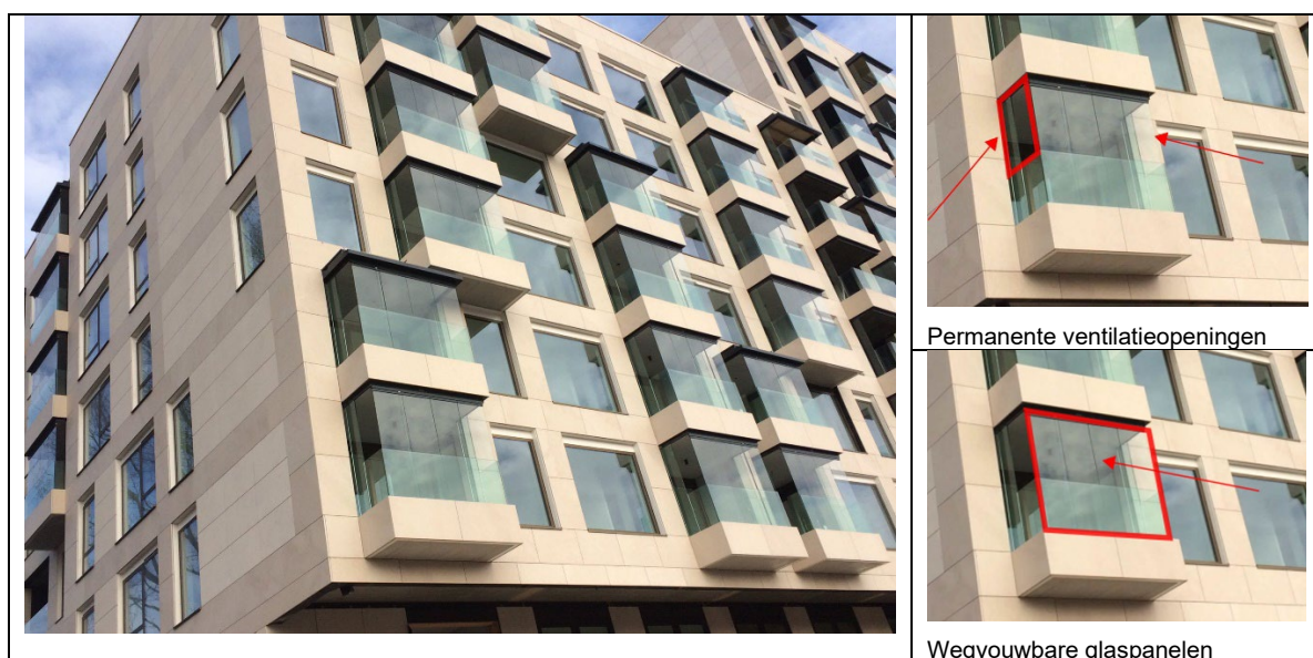
Figuur 6.1: Verglaasde balkons met ongedempte ventilatie-openingen
