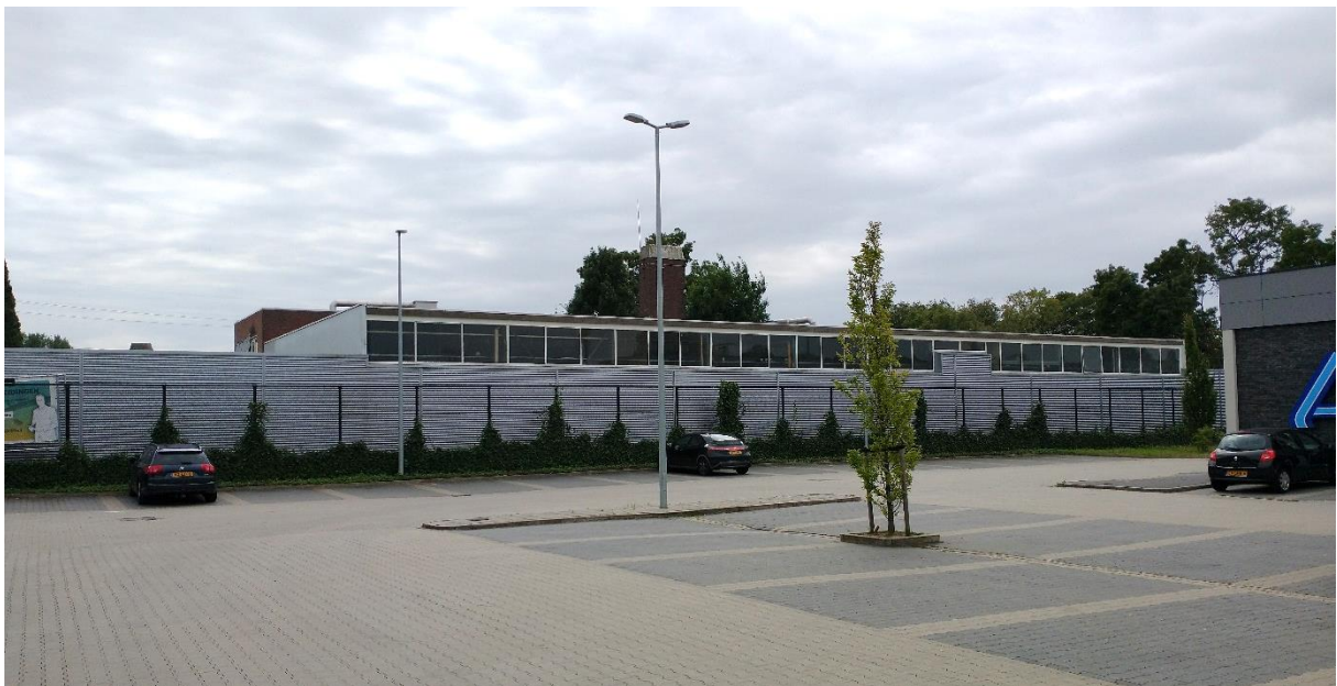
Huidige noordgevel (2020). Foto: Leon Sebregts
