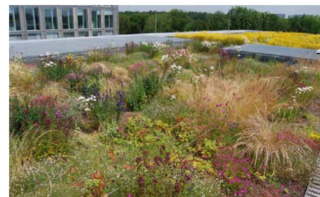
Water (tijdelijk) opgevangen en vertraagd afvoeren op groene daken
