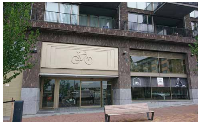
Inpandige gemeenschappelijke fietsenstallingen
