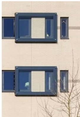
Figuur 10d: Impressie gevelscharm Metaglas SilentAir (reductie tot 15 dB)
