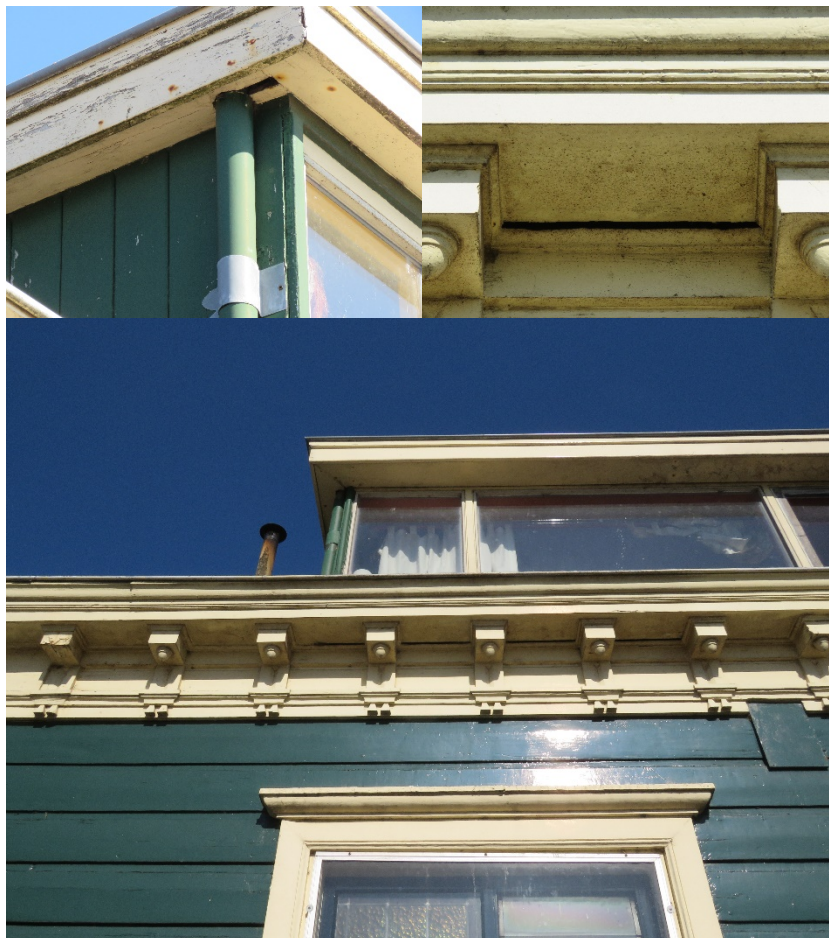
Figuur 3.1 Mogelijke verblijfplaatsen voor vleermuizen met linksboven een gat in afwerking van de dakkapel en rechtsboven en onder openingen in de dakafwerking.
