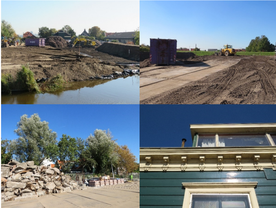
Figuur 2.2 Impressie van het plangebied met van linksboven met de klok mee: het plangebied gezien vanaf de westkant, het plangebied vanaf het terrein, de monumentale woning met opening/sleuf onder de goot en de te kappen bomen.
