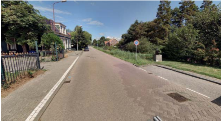
Figuur 4.2 Wegdek Zuideinde; klinkers
