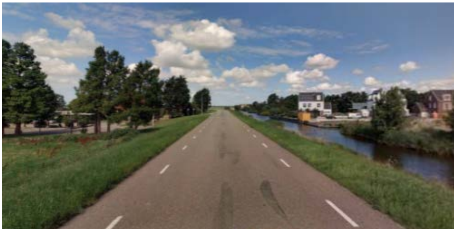
Figuur 4.3 Wegdek Overtoom; referentie asfalt
