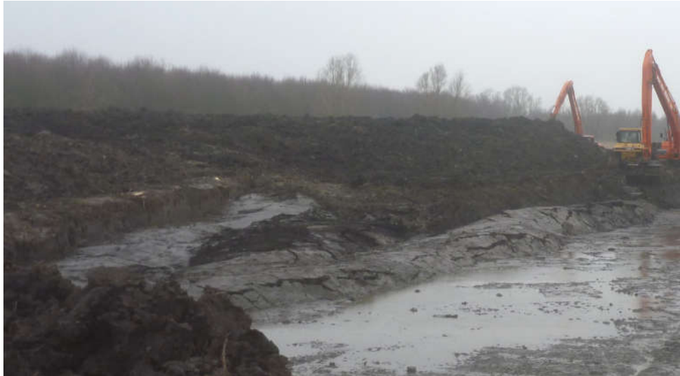
Afbeelding 1. Laterale vervorming en scheuring van een sterk samendrukbare grondlaag in het Kotterbos. De locatie was hieraan voorafgaand reeds archeologisch begeleid (Van Heeringen et al. 2014).
