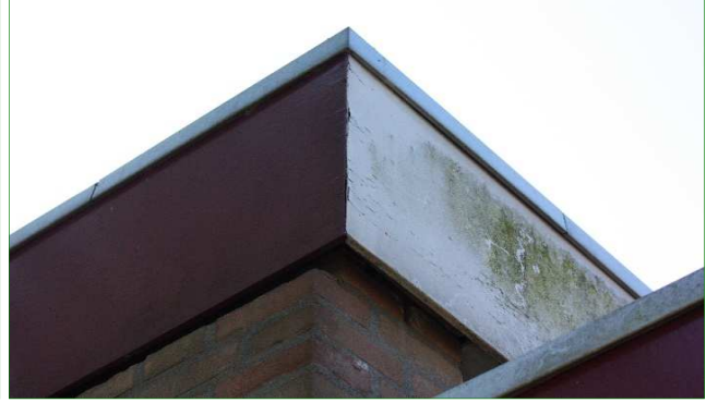
Ruimte onder gevelbekleding.
