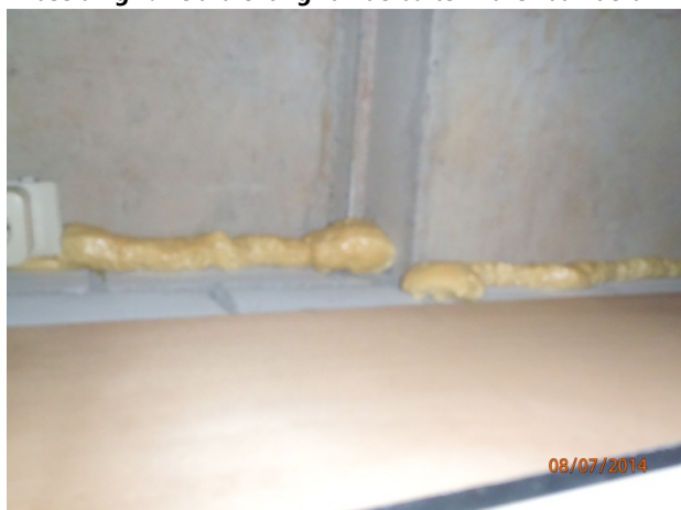
Afbeelding 7. De afdichting van de buitenmuren aan de binnenzijde en het plafond
