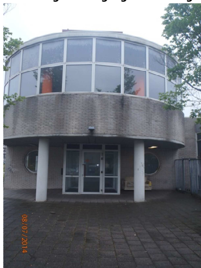
Afbeelding 4. De ingang van het leegstaande kantoorpand
