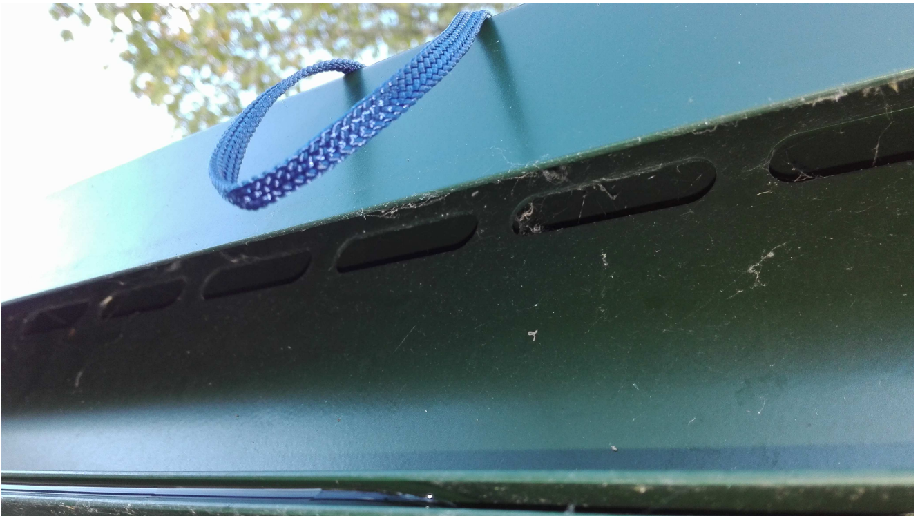
P:\072\072215aa\2. Foto's en afbeeldingen\2016-10-03 metingen gasverdeelststation\IMG_20161003_164656.jpg
