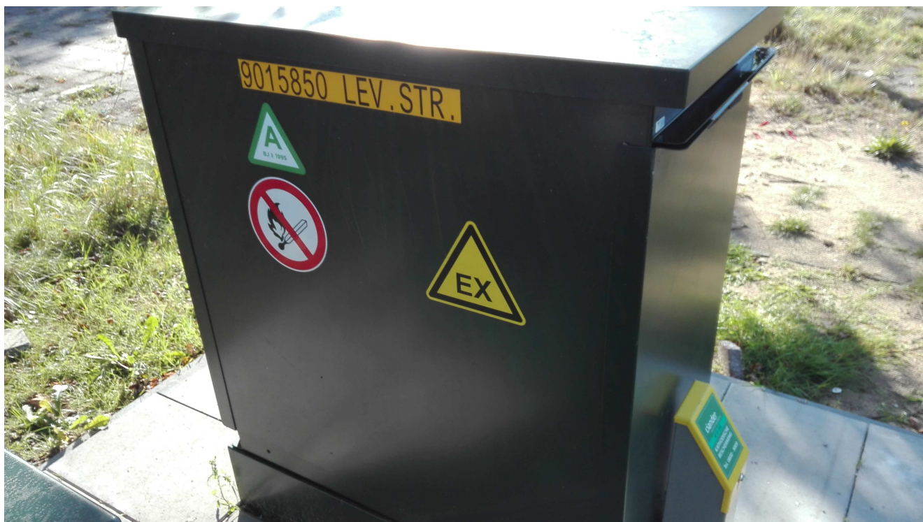
F:\072\072215aa\2. Foto's en afbeeldingen\2016-10-03 metingen gasverdeelststation\IMG_20161003_162739.jpg
