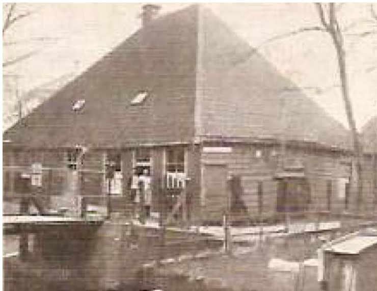
▲ Eerste kerk van Zandijk op haar latere plek, na verplaatsing naar Koog aan de Zaan. Deze is in de 20ste eeuw gesloopt.
