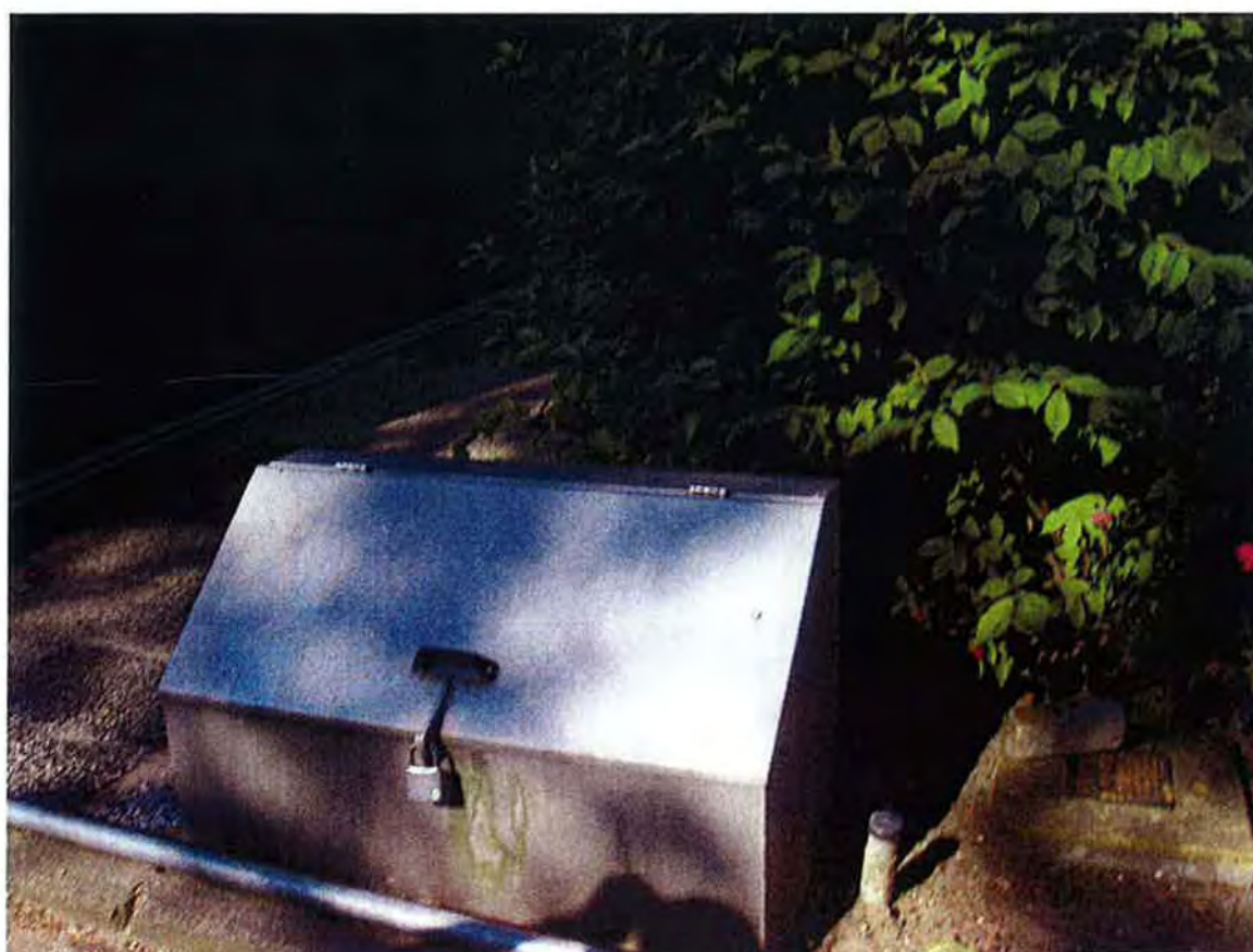
Foto 4 Vulpunt ondergrondse tanks
