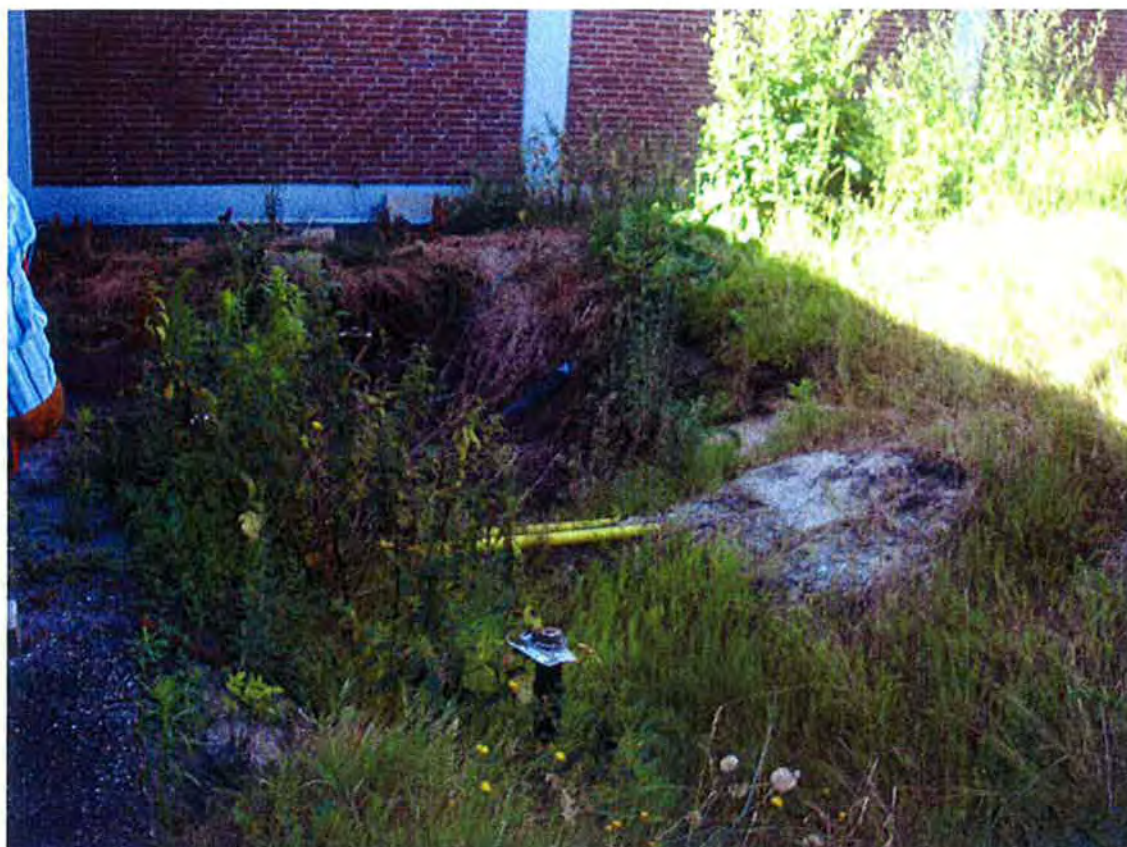
Foto 3 Locatie ondergrondse tanks
