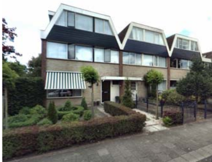
Tweelaags met toegevoegde dwarskappen
