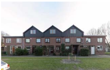
Tweelaags met toegevoegde dwarskappen
