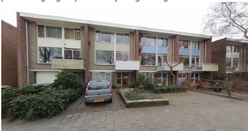
Drive-in woningen in de Vennenbuurt aan De Weer met individueel bij de woning getrokken garages
