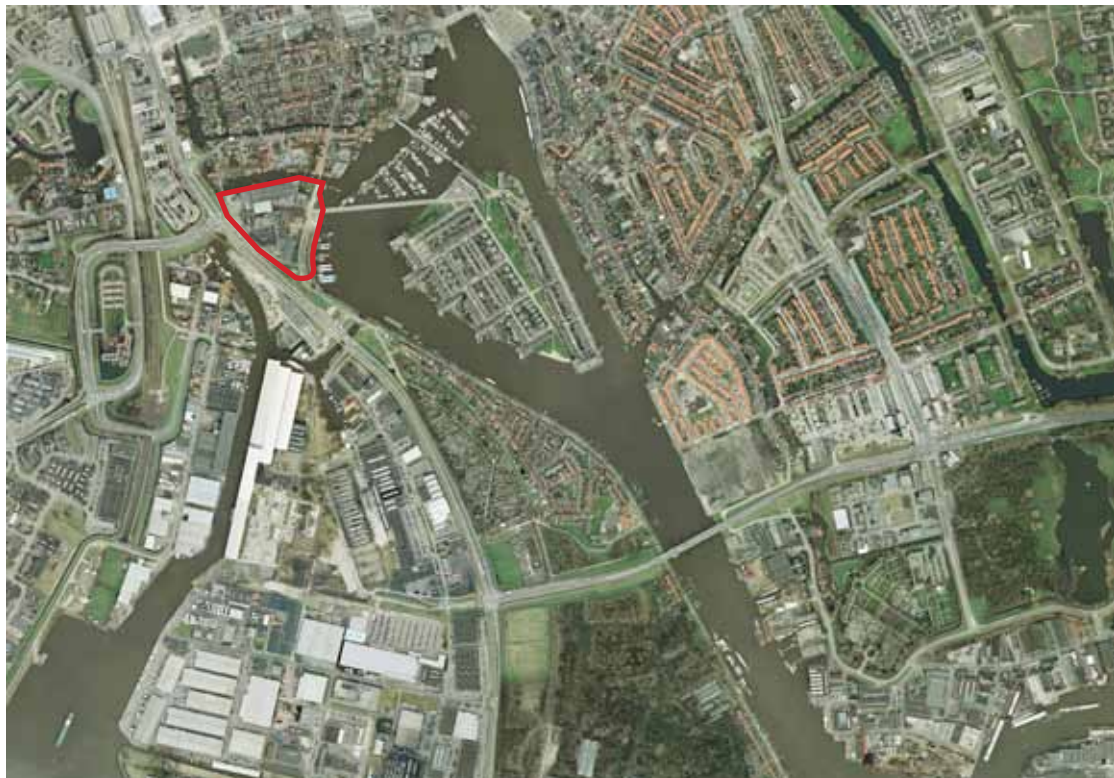
luchtfoto plangebied in grotere context
