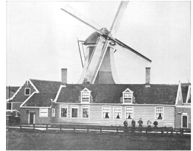
Blauwselmolen De Blauwe Hengst in Westzaan. Oorspronkelijk was deze molen een witpapiermolen en daarom is deze molen met hout bekleed. [Huslage 1968]
