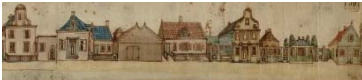
Fragment van de Westzijderol, tweede helft 18 e eeuw. Afgebeeld is de even kant, langs de Zaan. Te zien is de afwisseling van gebouwen, molens, tuinen, sluisen en doorzichten naar de Zaan en de verdichting die in deze periode al aanwezig was. [GAZ]
