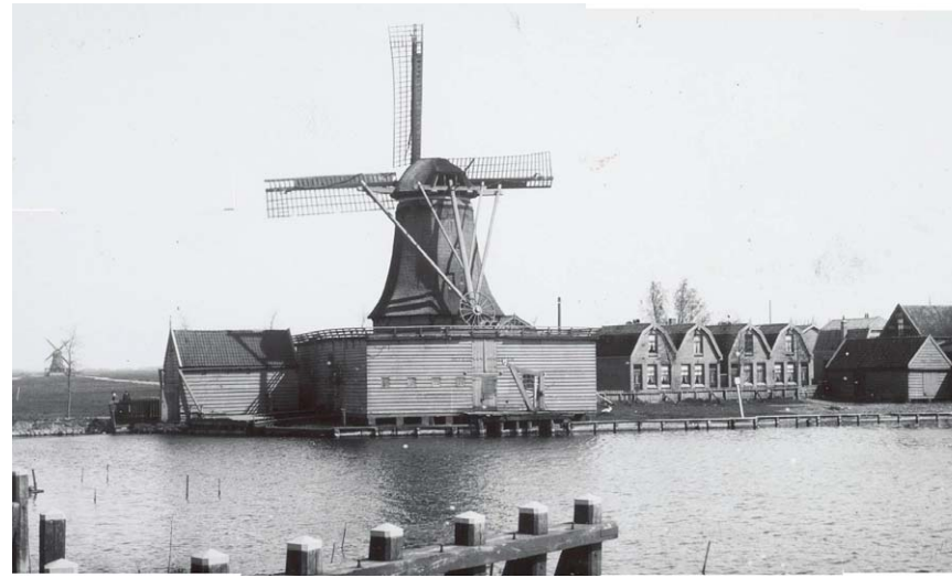
Oliemolen Het Rad van Avontuur, gebouwd in 1648 en gesloopt in 1915. De molen week af van zijn soortgenoten, door het ontbreken van een met pannen gedekte molenschuur. Hij stond op een vierkant pakhuis met plat dak, dat diende als stelling. [GAZ]
