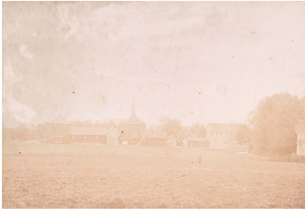
Achterzijde van het Gorterspad in Zaandijk, 1910. Aan het pad stonden arbeidershuizen, een boerderij en grote schuren. [GAZ]
