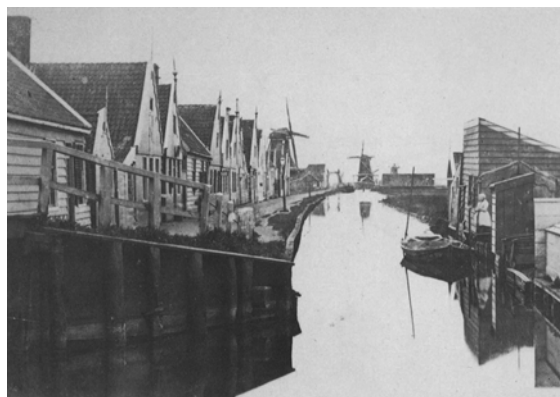
Vaak werden bestaande paden (bijvoorbeeld naar molens of andere dorpen) bebouwd, zoals hier het Guispad dat Zandijk verbond met Westzaan. [Woudt et al. 1986]
