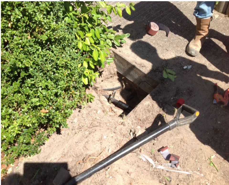
Foto 2: Locatie boring 007 gasleiding
