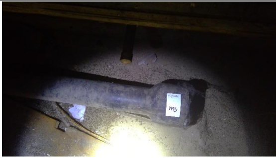
Foto voor Bron 4 Rioleringsbuis
