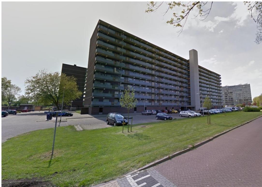
Afbeelding 3 Bestaande situatie plangebied
