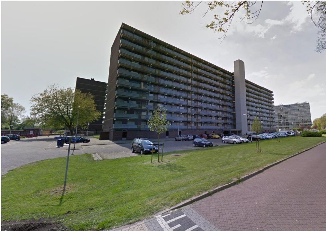
Afbeelding 3 Bestaande situatie plangebied
