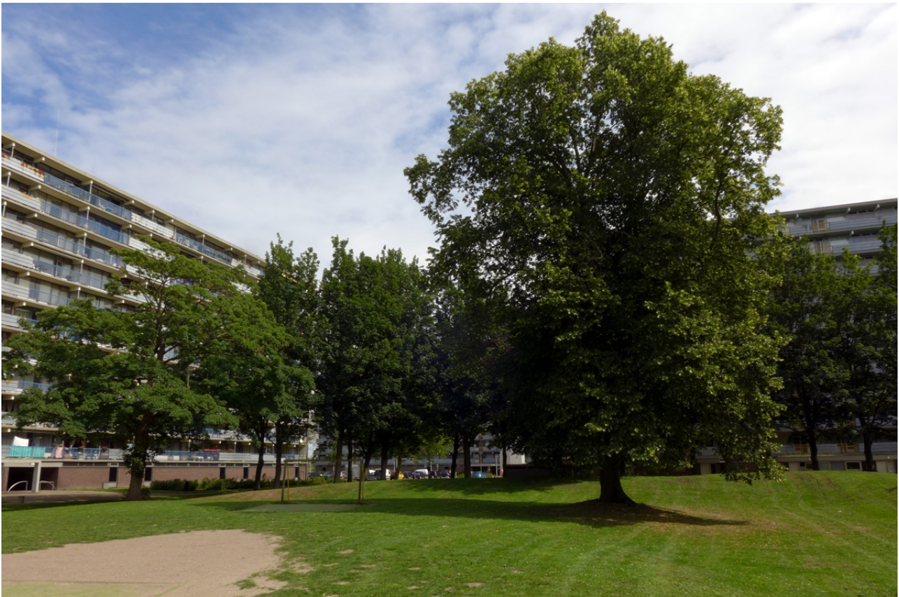
Afb.2: Twee van de flats met daartussen gelegen groenstructuren in de vorm van gazon met bomen.
