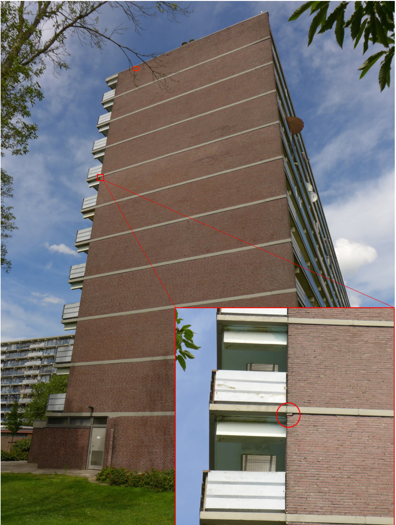
Afb.5: Paarverblijf en 2 zomerverblijven van gewone dwergvleermuis in de zuidelijke kop van de Gasperiflat.
