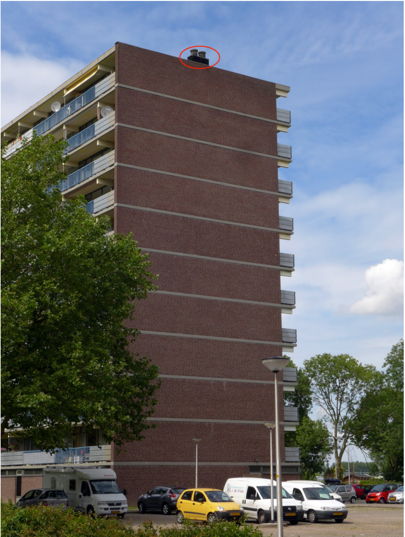
Afb.6: Zomererblijfplaats van gewone dwergvleermuis in de schoorsteen van de Churchillflat.
