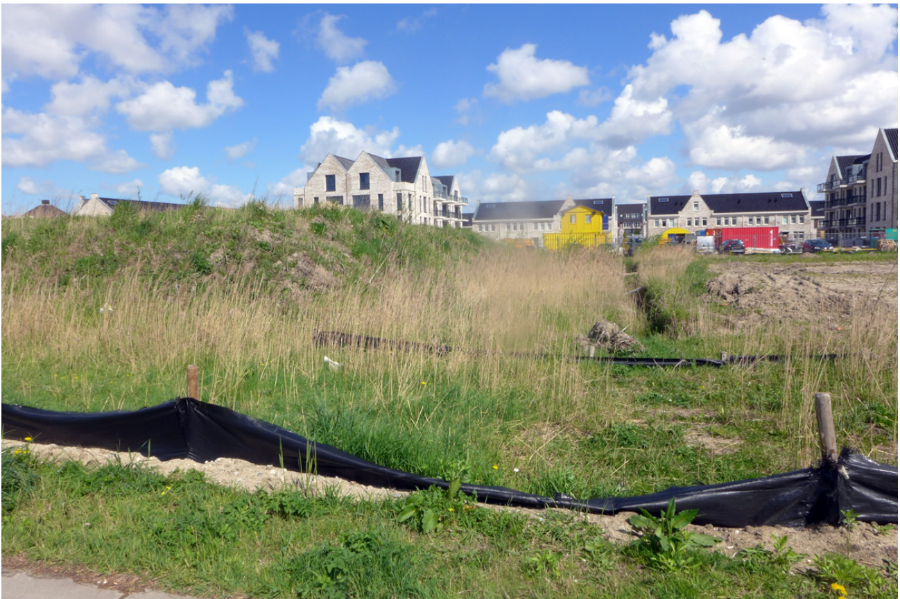
Afb.4: Doek tegen amfibieën. Slecht aangelegd en/of onderhouden. Plangebied voor amfibieën bereikbaar.
