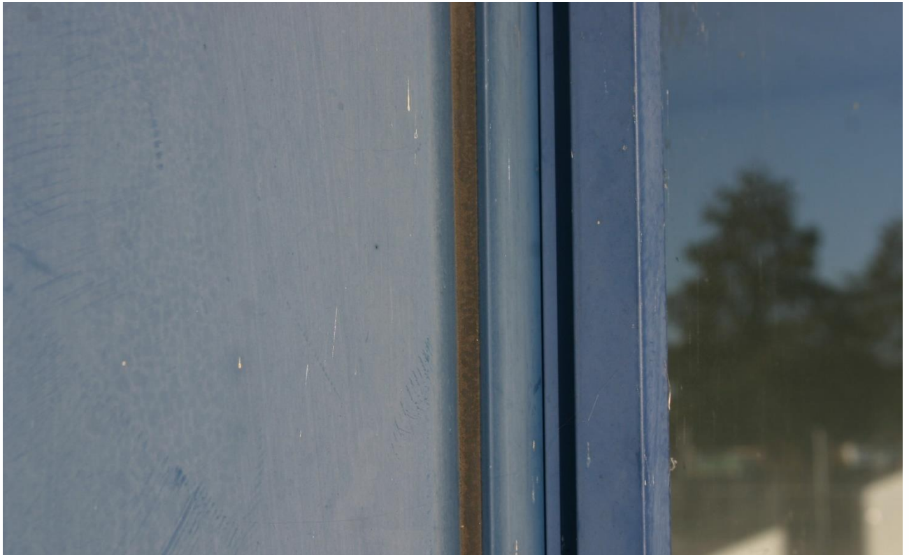
Figuur 4.4.2. Naast de kozijnen zijn nergens openingen aanwezig waardoor vleermuizen naar binnen kunnen.
