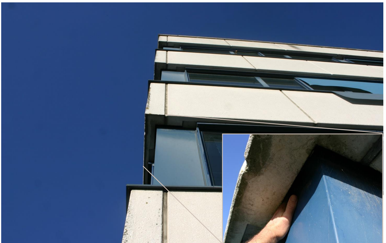
Figuur 4.4.3. Onder de betonnen wandplaat is genoeg ruimte voor vleermuizen om in te vliegen. De blauwe wand is echter veel te glad; vleermuizen krijgen hierop geen grip.
