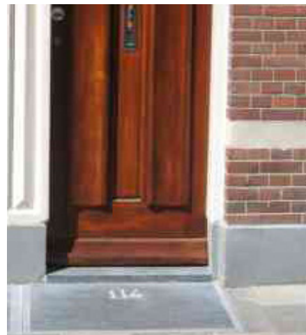
plint met ambachtelijke detaillering
