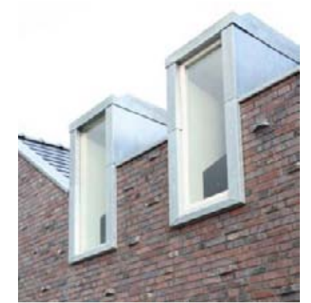
dakkapellen vormen zelfstandig element
