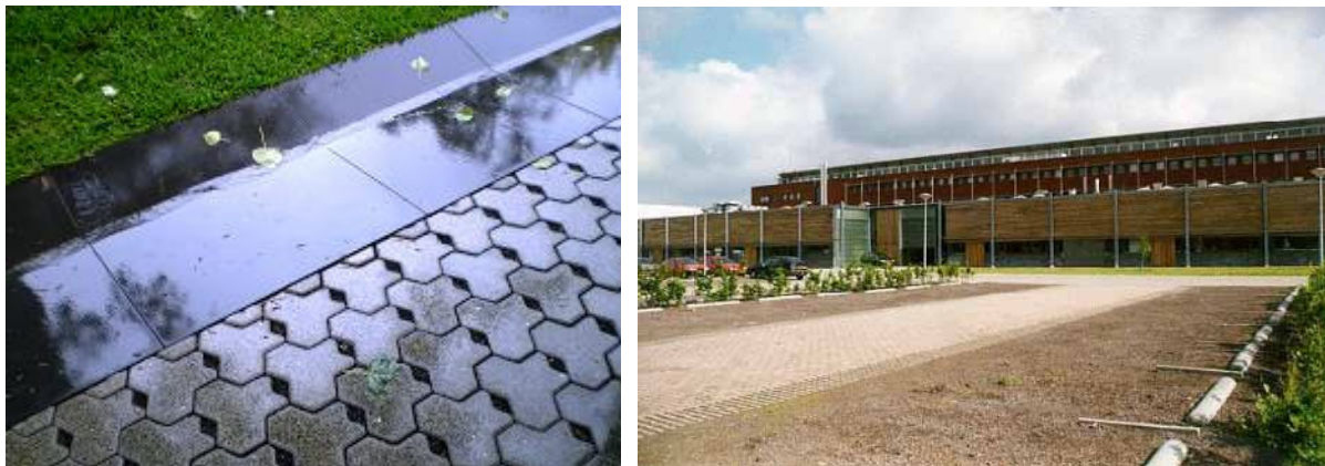
Figuur 13 Voorbeelden van waterpasserende of half verharding
