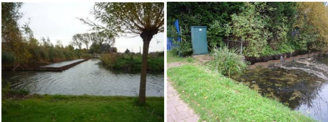
Figuur 4 Damwand Cindu terrein langs Thamersloot (links) + pomp en damwand als scheiding peil (NAP -1,96 m) en waterkwaliteit
