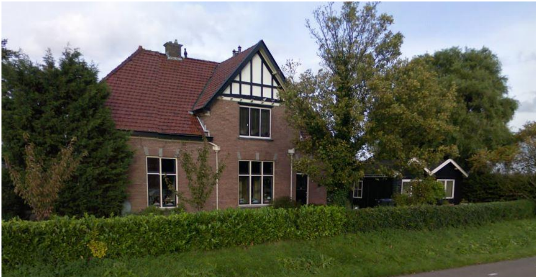
Afbeelding 3 Voormalige baanwachterswoning (Bron: Google maps)
