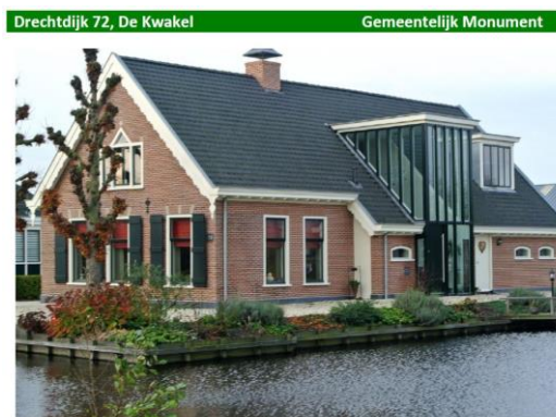
Gemoderniseerd monument Drechtdijk 72
