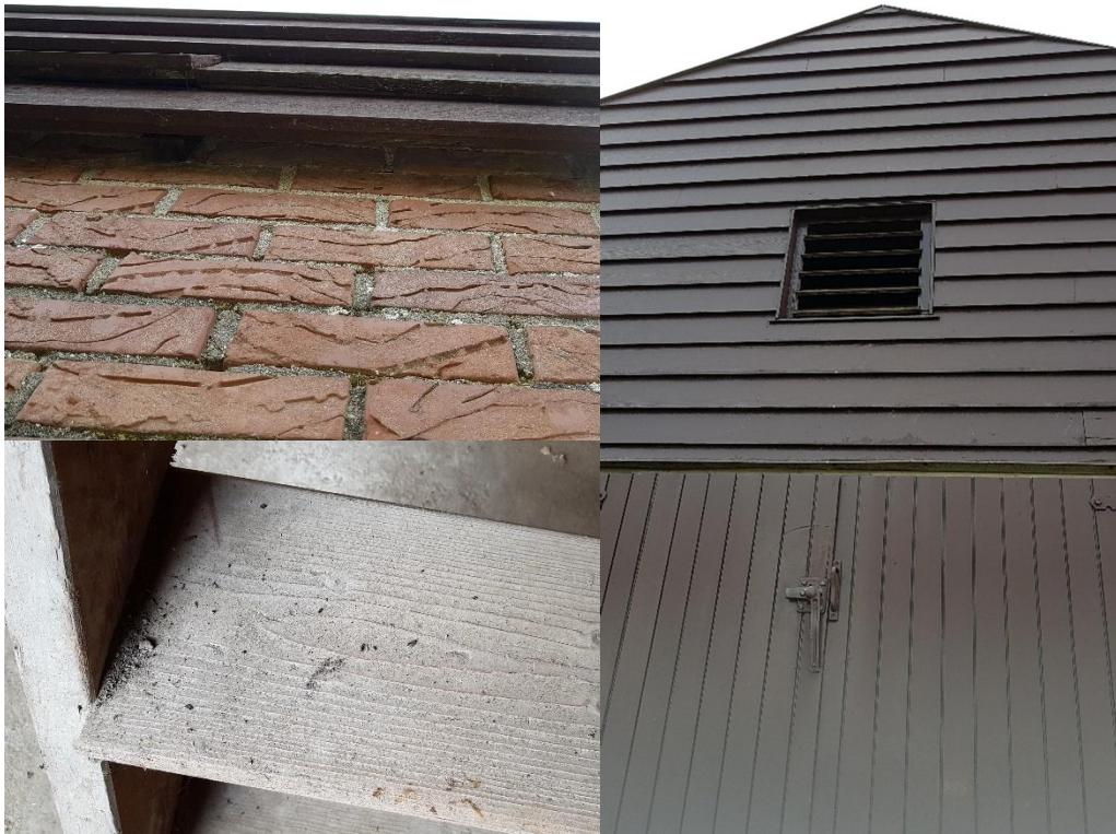
Figuur 11. Sporen/aanwijzingen van vleermuizen in gebouwen.
