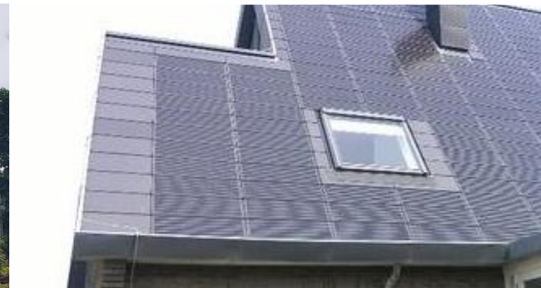
Geïntegreerde zonnepanelen op een huis in Callantsoog (Foto: Kees van der Leun)
