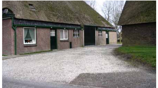
Afb. 29: Referentiebeeld oprit van schelpenverharding
