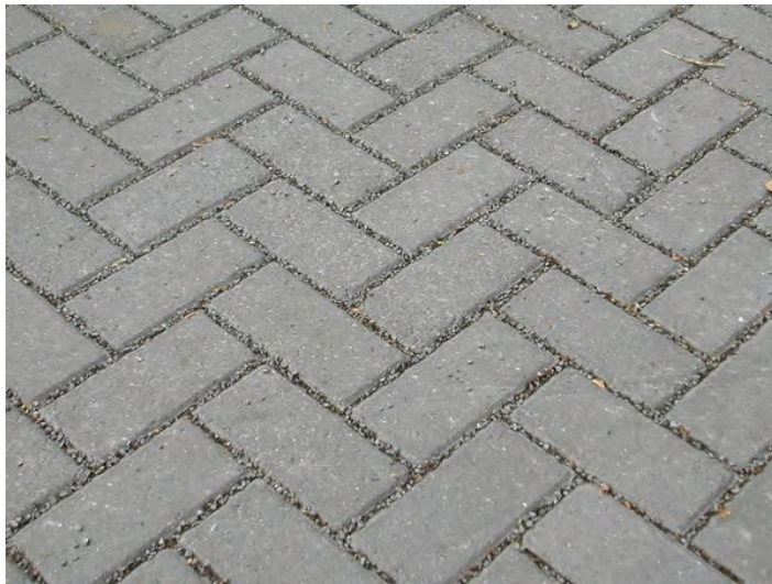
Bestrating rondom station Waterdoorlaatbare betonklinkers grijs
