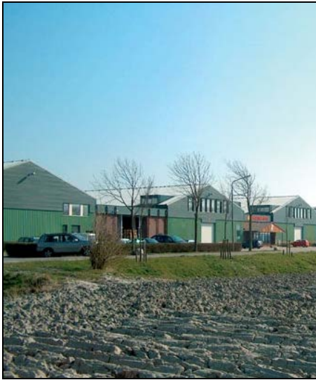
Figuur 14. Blankendaal Coldstores
