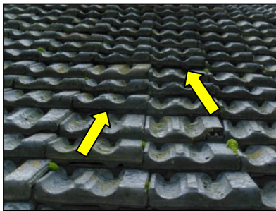
Figuur 10. Ruimte onder dakpannen.
