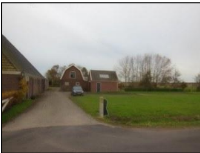
Figuur 3. Schuur/ garage middendeel onderzoekslocatie.
