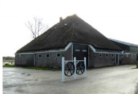
De stolpboerderij met daarachter de aangebouwde grote schuur.
