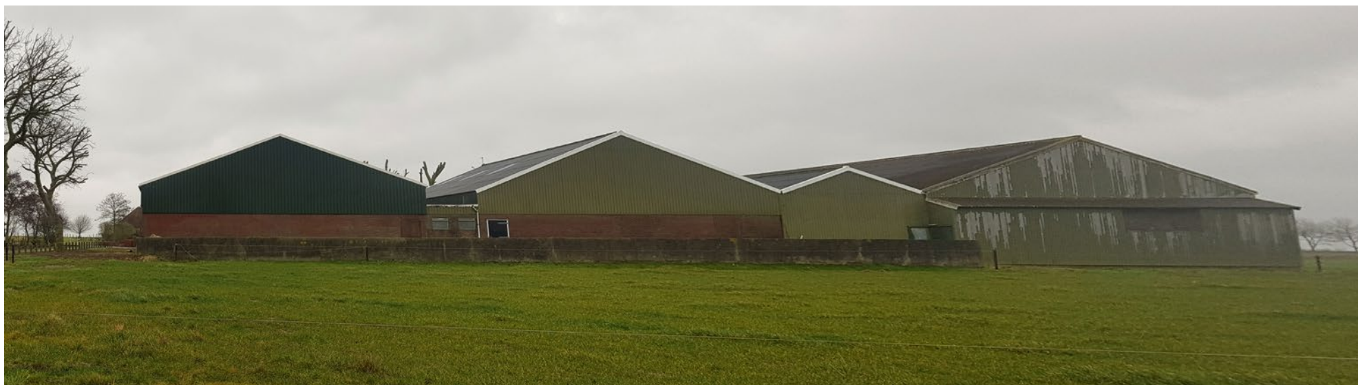
De aan elkaar gebouwde schuren gezien vanaf de Keins in het zuidwesten van het plangebied. Het schaalverschil van de verzameling van schuren ten opzichte van de woning aan de andere kant van de weg in het buurtschap is groot. Het toegepaste materiaal- en kleurgebruik van de gebouwen onderling en in relatie tot het landschap is afwijkend.
