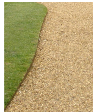
Referentie, oprit van halfverharding
