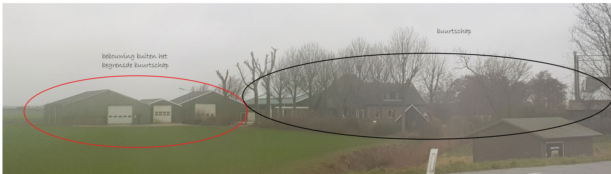
De meest zuidelijke opstallen (links) belemmeren het zicht vanaf de Westfriese Omringdijk over het weidse landschap, rechts in beeld de stolpboerderij met de grote schuur daarachter.
