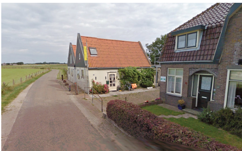
Halerweg 13 bestaande bebouwing
