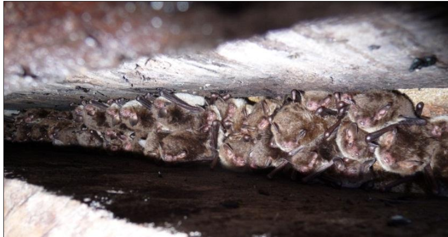
Figuur 19. Kolonie watervleermuis in kruipruimte
